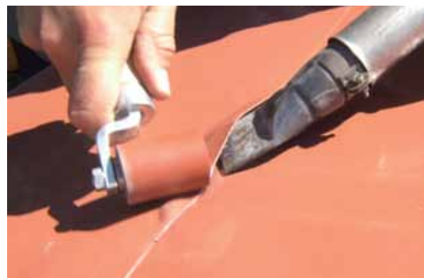
6 Stöße thermisch verschweißen, die kritischen Stöße an der Traufe bearbeiten
