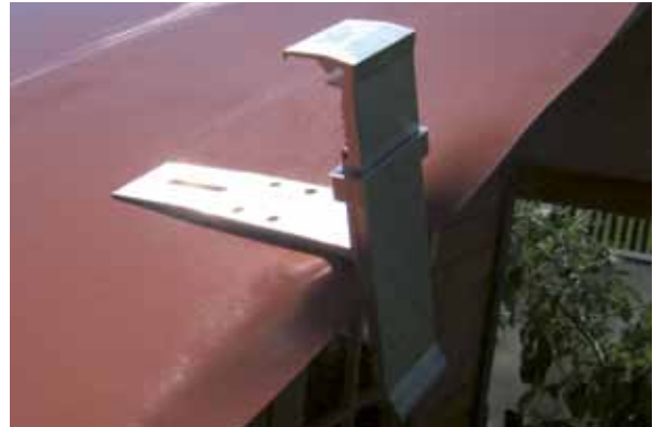
8 Halter für die Ortgangabdeckung anbringen
