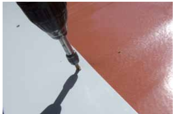
4 Tropfblech mit Schrauben befestigen
