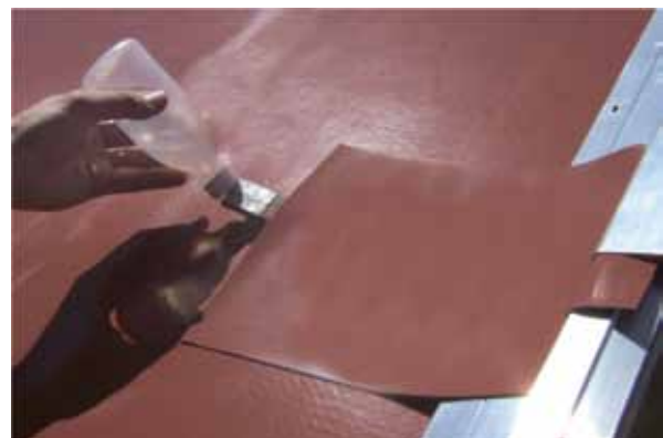
12 Mit Lösemittel verschweißen
