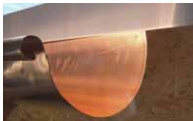
Beispiel Anschlussdetail Traufe (Alwitra Evalon V)
