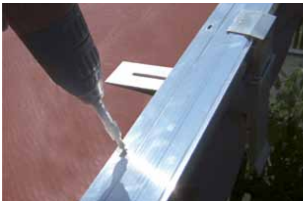
9 Anschlussblech klemmen und verschrauben
