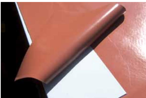
5 Traufkante abdecken und mit Lösemittel verschweißen
