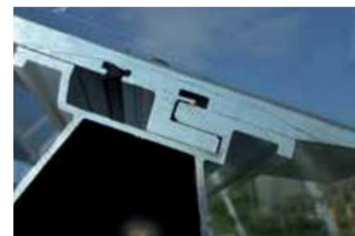
**Bitte beachten:** Optibond-Module im Dachverbund (dachparallel) ohne Diebstahlsicherung verbauen, da ansonsten eine Demontage einzelner Module im Verbund nicht möglich ist.
