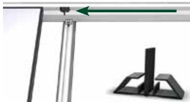
Zwischen den Modulen - oben: Distanzhalter an das eingelegte Modul anlegen
