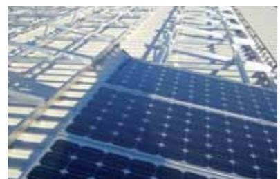
**Beachten Sie bitte, dass bei dieser Montageart die Dachhaut die auftretenden Windlasten sicher aufnehmen und in die Unterkonstruktion einleiten muss! Dies ist unbedingt bauseits nachzuweisen! Im Zweifelsfall ist eine Befestigung an der Unterkonstruktion einer Befestigung an der Dachhaut immer vorzuziehen.**
